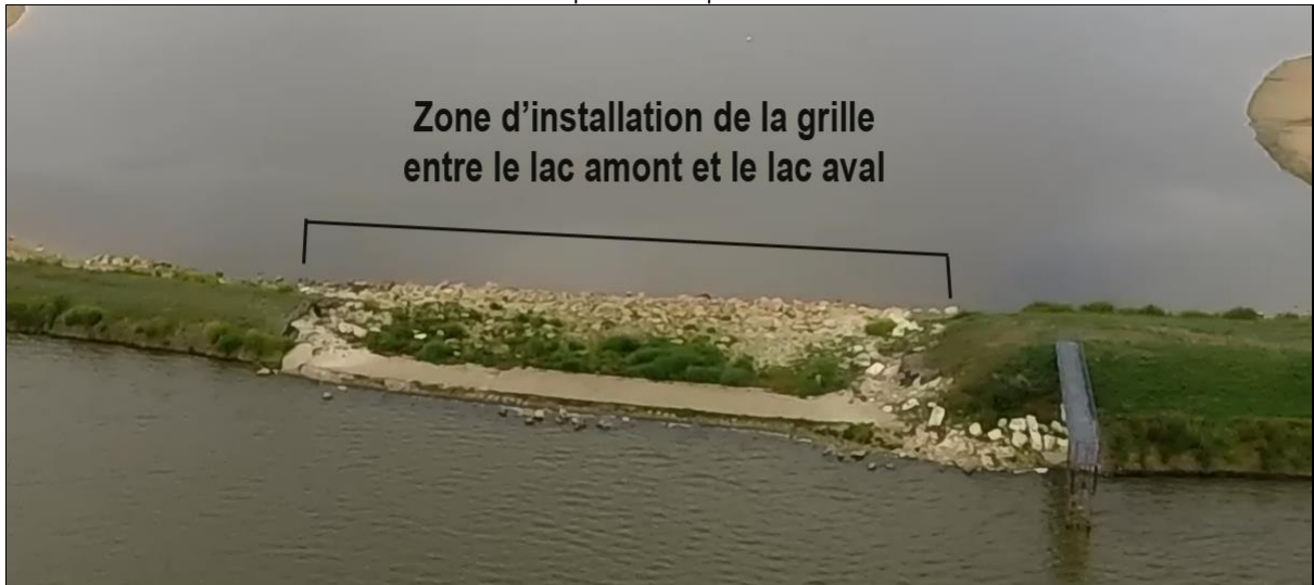
La certitude d'un niveau d'eau stabilisé entre 11,50 et 12 mètres au barrage.
